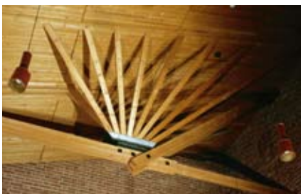
Dachkonstruktion im Gemeindehaus von Säynätsalo.
