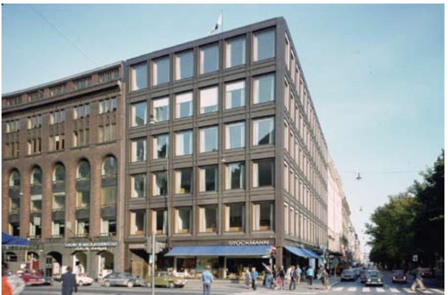
Das Gebäude der Akademischen Buchhandlung. Foto Kari Hakli
